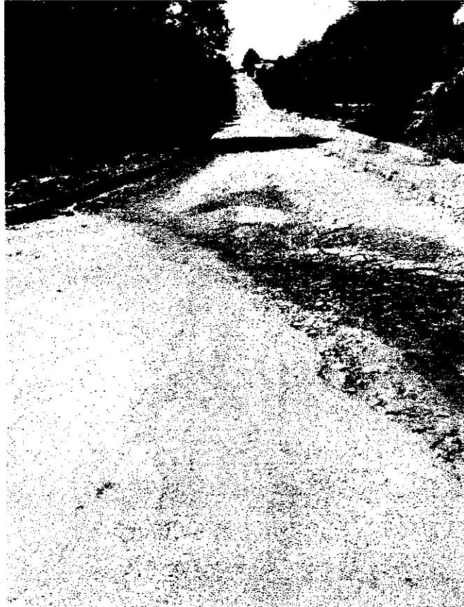
Figura 1 - Situação atual da rua Antônio Batista.
