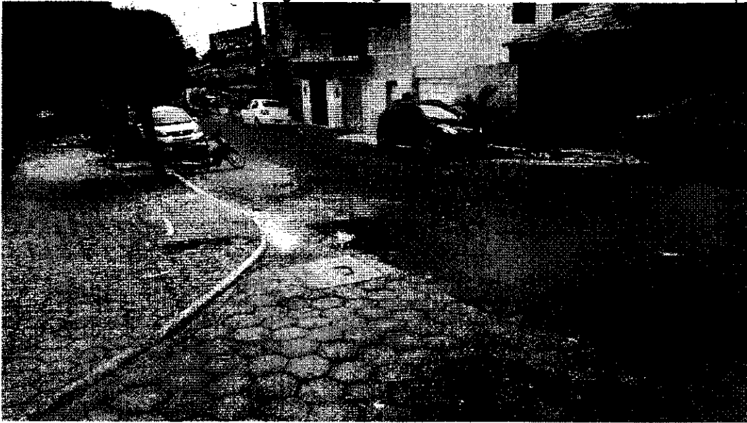
Foto 5 – Drenagem de esgoto da rua Leontino Nascimento.
