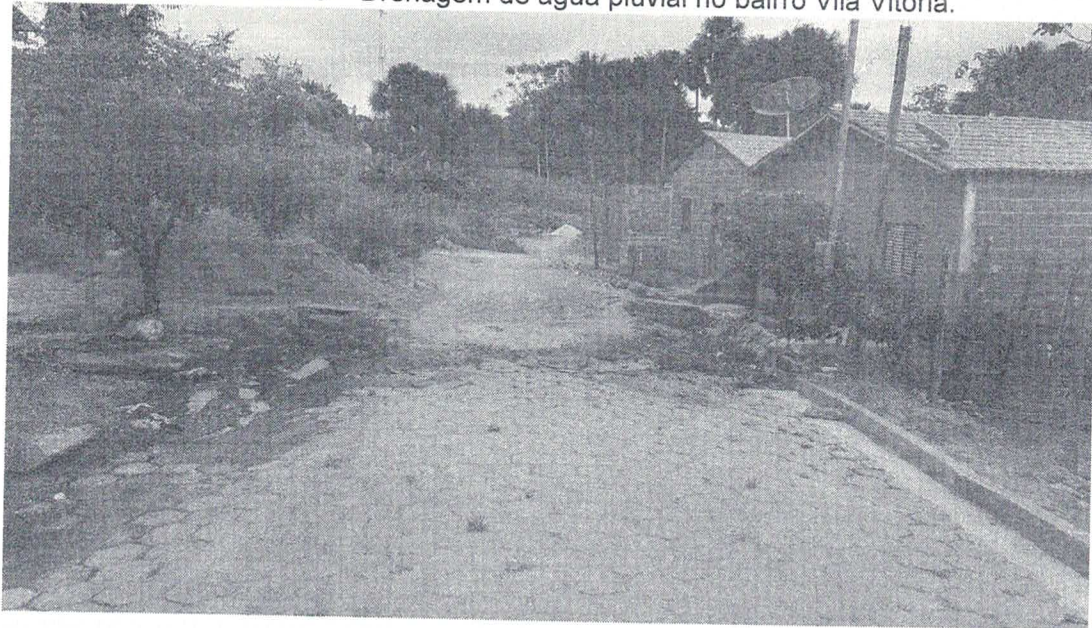
Foto 6 – Drenagem de água pluvial no bairro Vila Vitória.
