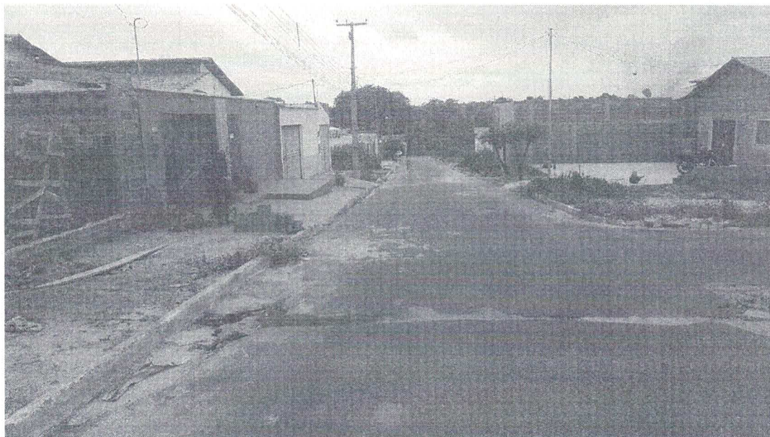
Foto 3 – Drenagem de água pluvial do Setor Loteamento Mundico Nascimento.
