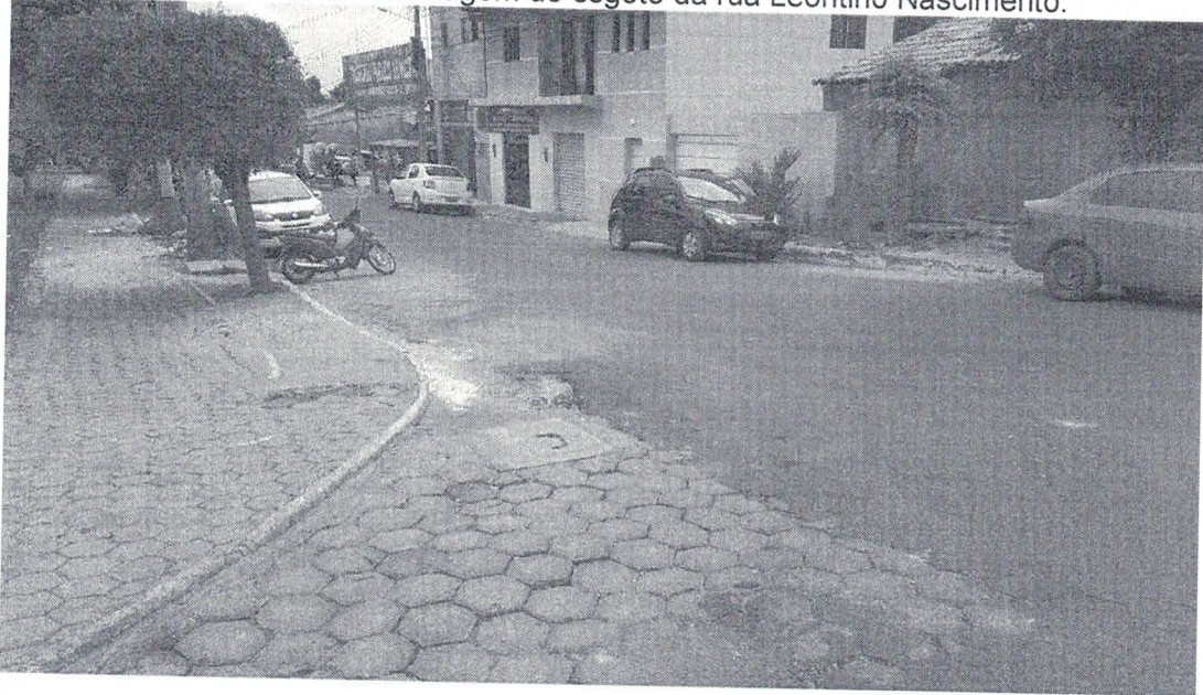
Foto 5 – Drenagem de esgoto da rua Leontino Nascimento.
