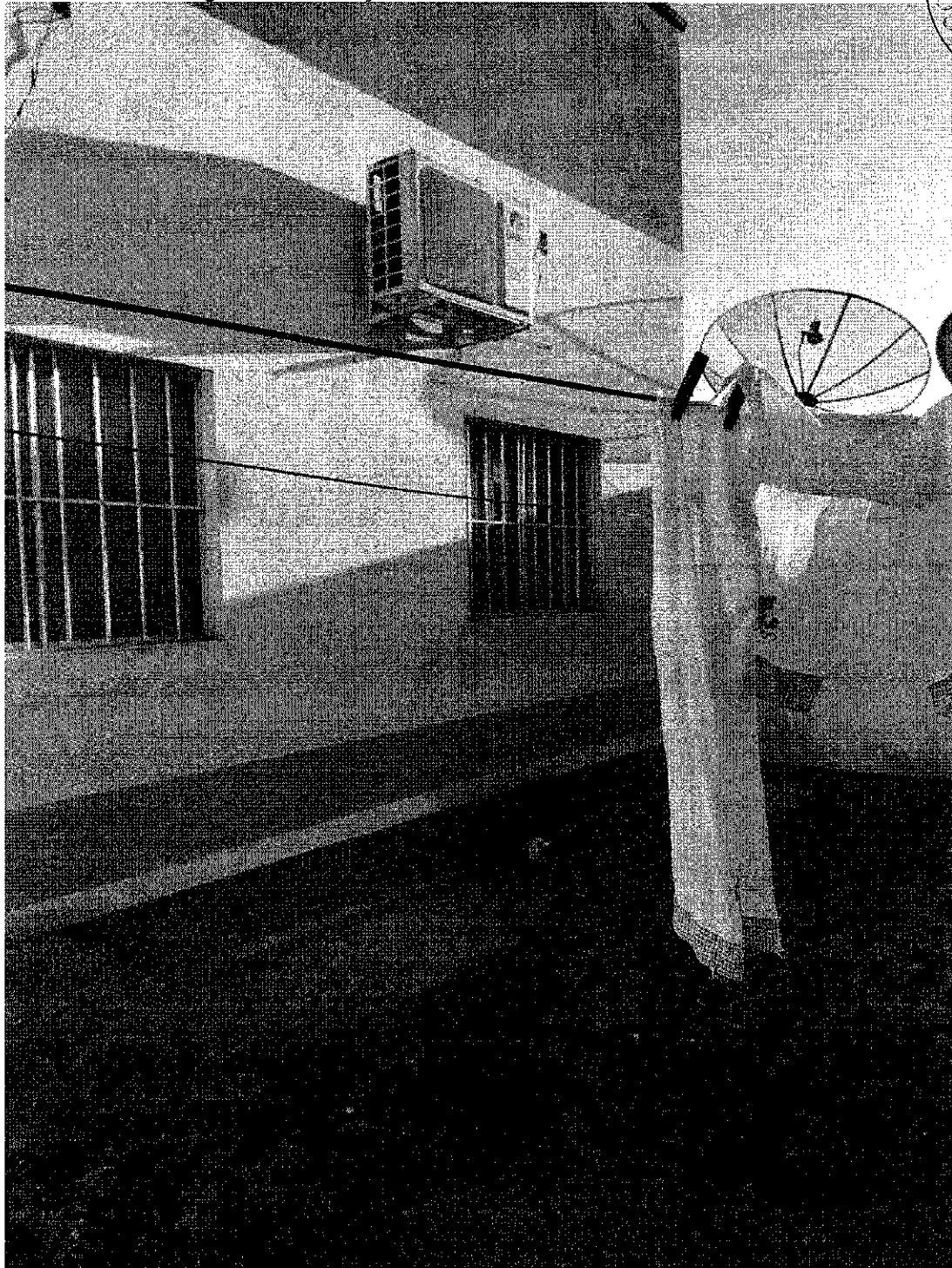
Figura 2 – Situação atual da área externa do SAMU.
