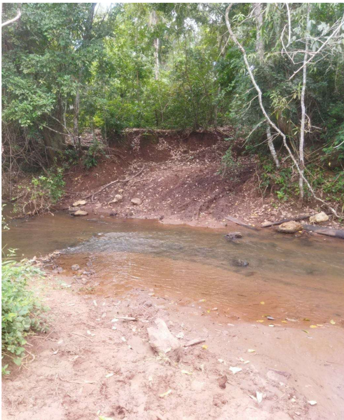
Figura 2 - Vazão de água do riacho Colodino, onde será implantada obras de arte corrente, no desvio 02.
