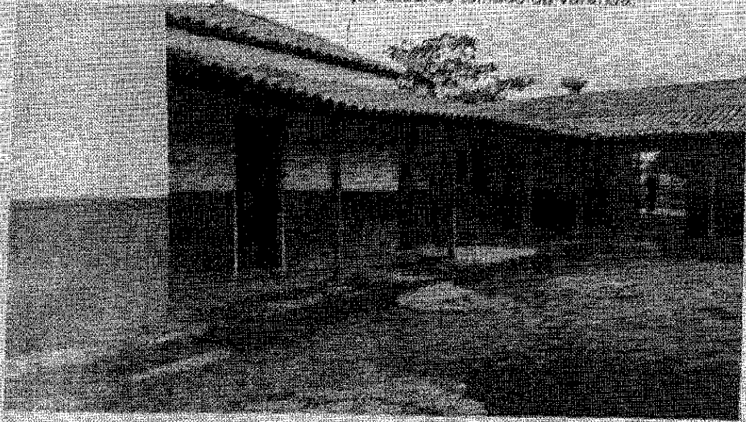
Figura 29 - Situação atual do telhado da varanda
