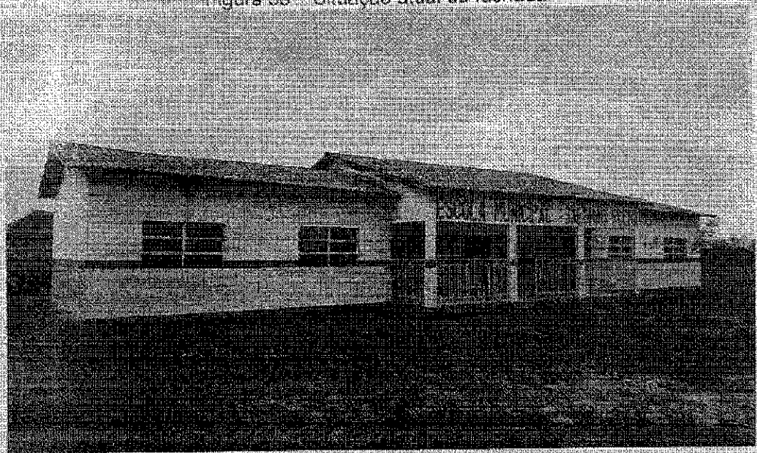
Figura 35 - Situação atual da fachada
