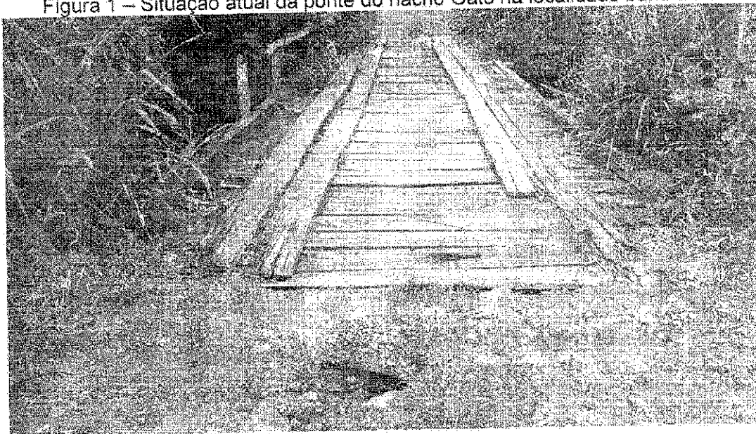
Figura 1 – Situação atual da ponte do riacho Gato na localidade buritirana.
