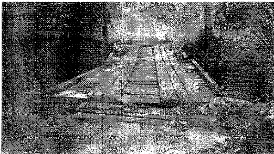
Figura 25 – Situação atual da ponte do rio Santana na localidade estrada do veredão.
