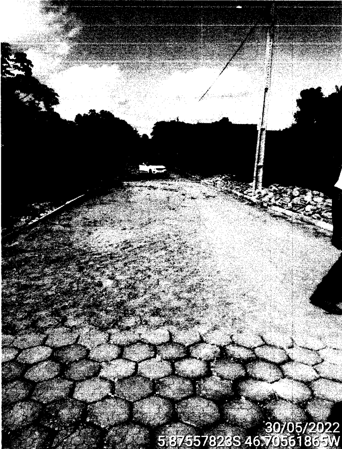
Figura 2 - Final do trecho da rua a ser recuperada.
