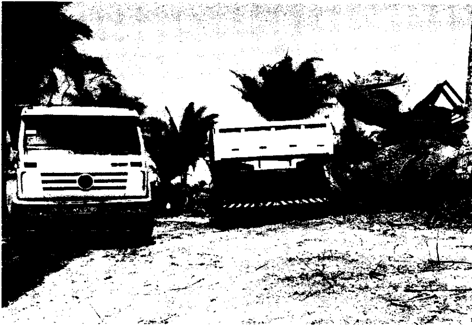
PIÇARRA DE JAZIDA PARA BASE DE PAVIMENTAÇÃO
