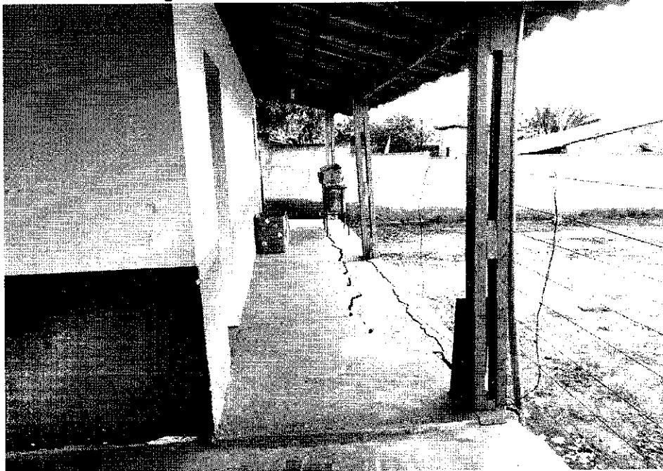
Figura 27 – Estado atual de piso externo.
