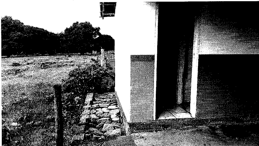
Figura 31 – Estado atual do piso da calçada.
