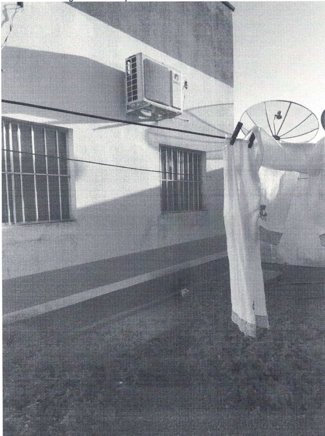
Figura 2 – Situação atual da área externa do SAMU.
