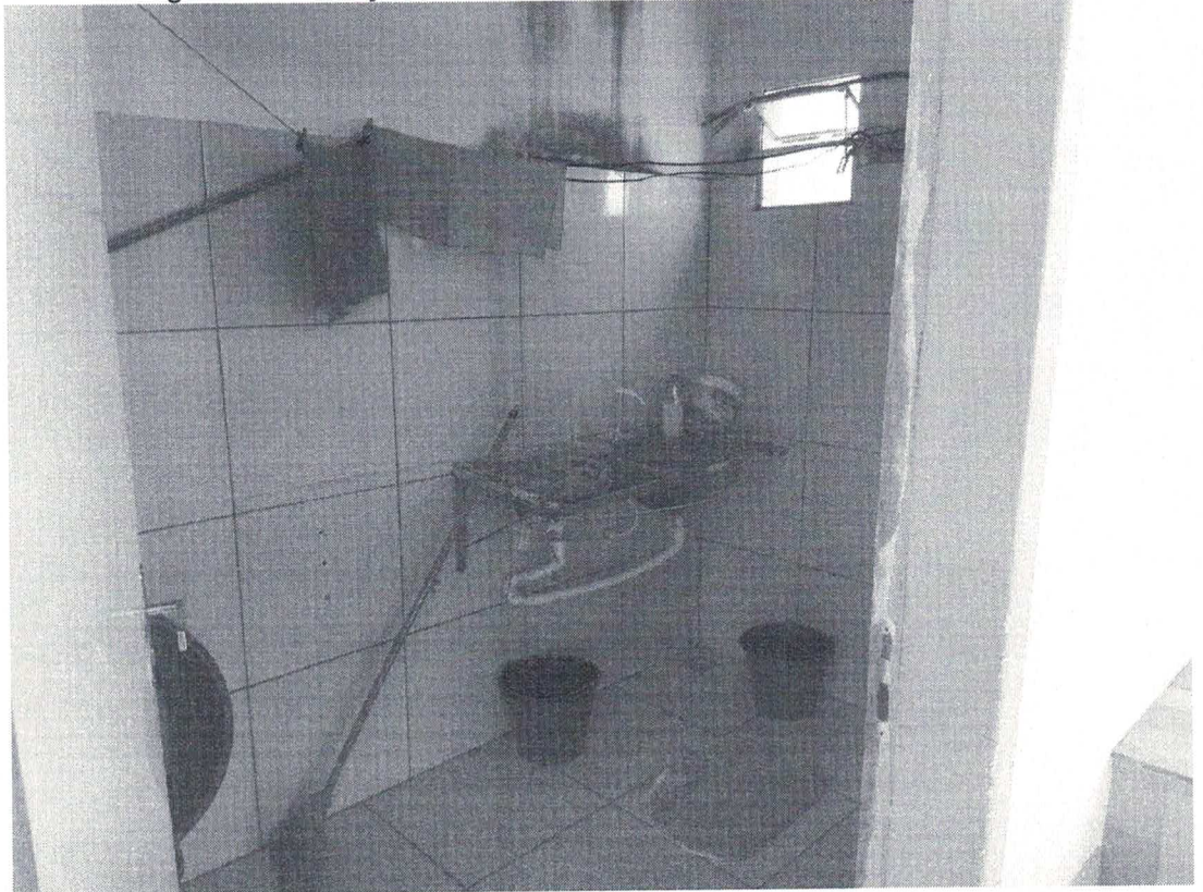
Figura 3 – Situação atual da lavanderia do SAMU.
