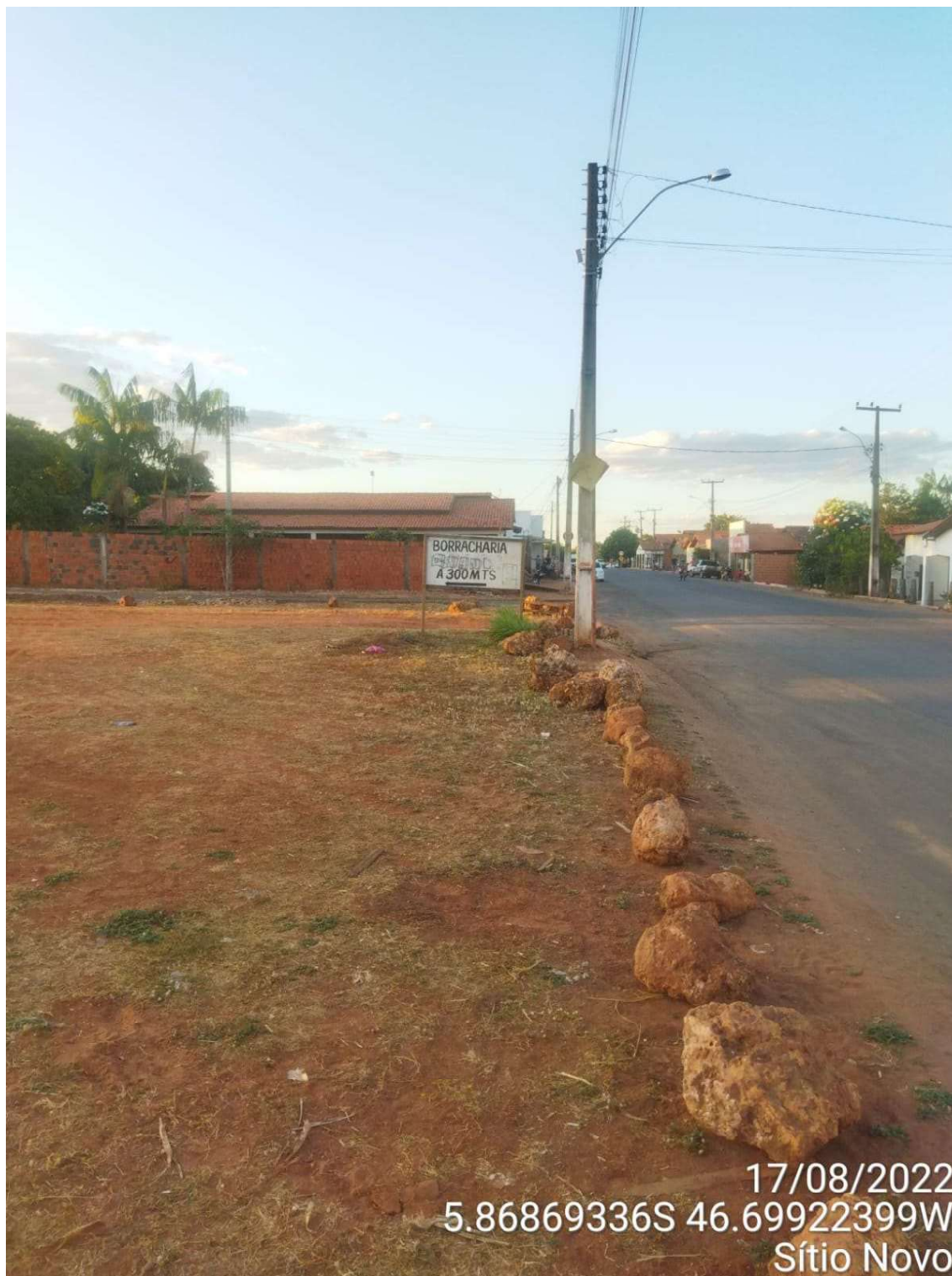
Figura 1 – Início da área onde será construída a praça.
