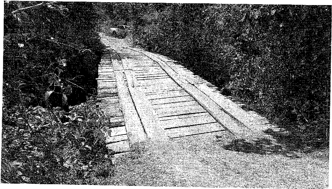
Figura 5 – Situação atual da ponte do rio santana na localidade água preta.
