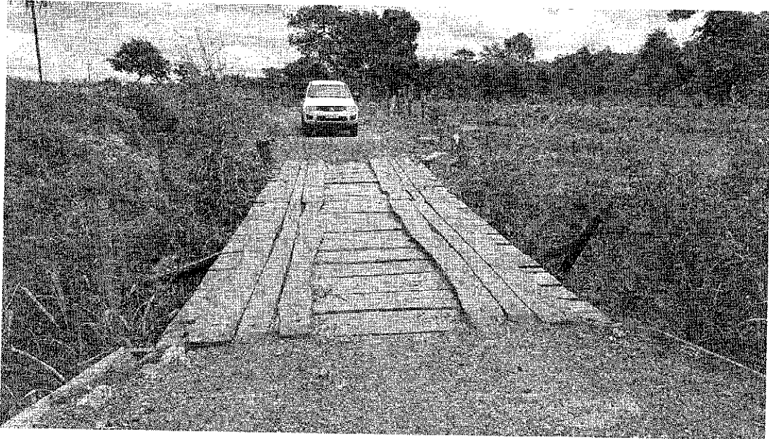
Figura 4 – Situação atual da ponte do riacho bom jesus na localidade agrovila água branca.
