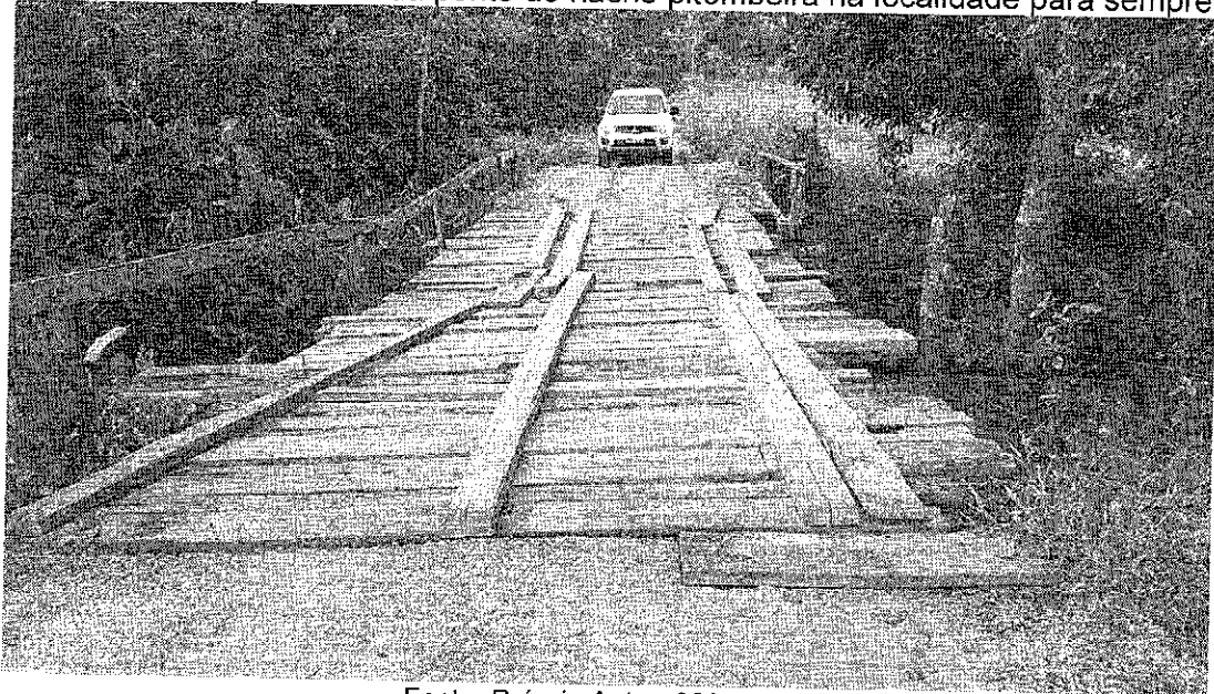
Figura 8 – Situação atual da ponte do riacho pitombeira na localidade para sempre.
