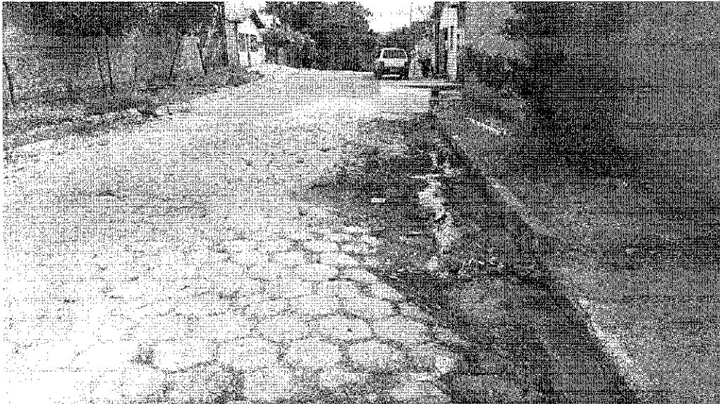
Figura 3 – Pavimento em bloquete com meio fio e sarjeta desgastada
